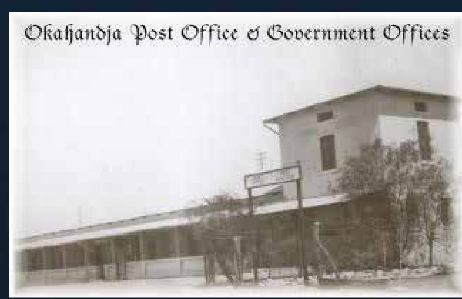
Okahandja Poštovní úřad Okahandja Post Office
